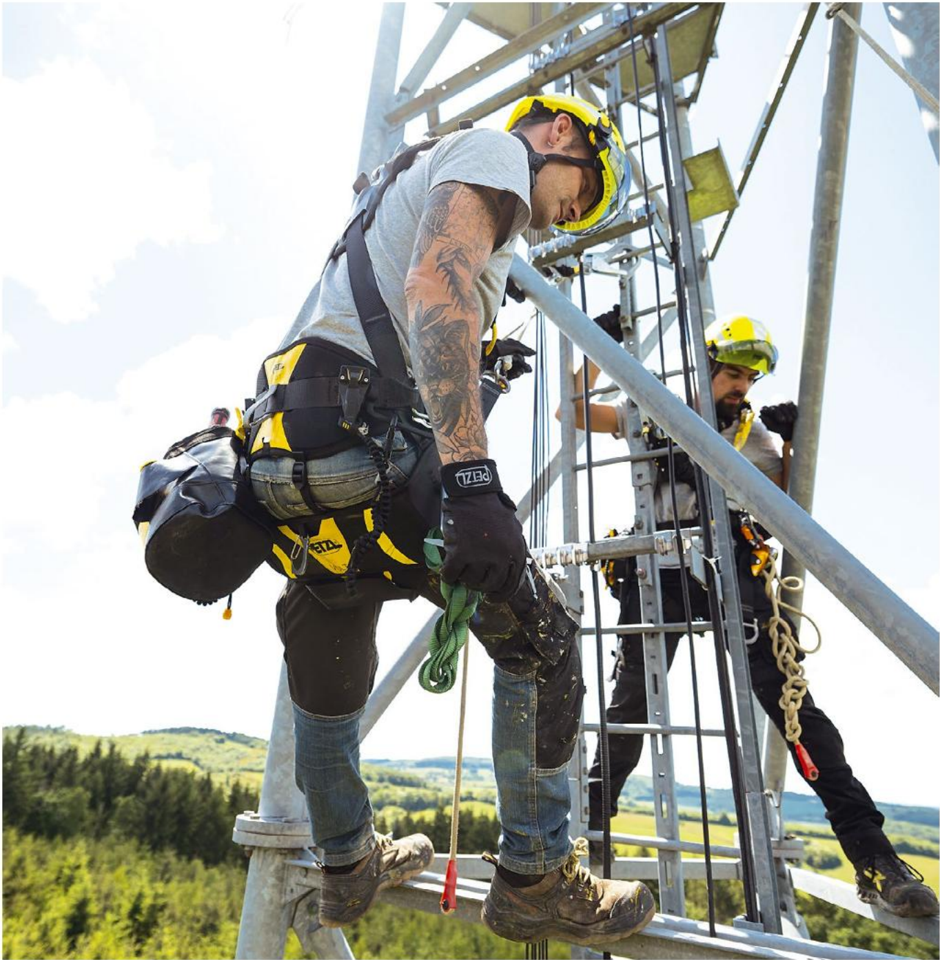
Um sich der individuellen Körpergröße aller Anwender und Anwenderinnen bestmöglich anzupassen, verfügen die Petzl-Gurte über Einstellmöglichkeiten im Hüft-, Schulter- und Beinbereich. Sie sind mit verschiedenen Schnallen ausgestattet:
